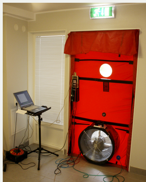
ByggaL innehåller bland annat beskrivning av tidig läckagesökning och slutlig tätthetsprovning. På bilden syns en Blower-Door utrustning som används vid en tätthetsprovning för att se om lufttätetskravet uppfyllts.
