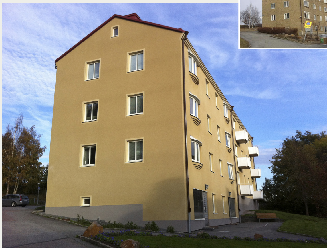
Kyrkbyn efter renovering.
