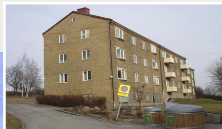
Kyrkbyn före renovering.
