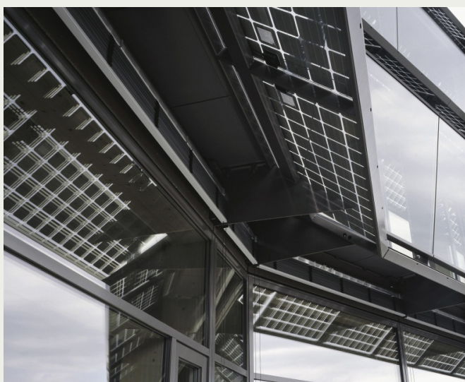
Fotot visar en detalj från byggnaden Dreieck GHC i Schweiz, ett passivhus-kontor med hög andel förnybar energi från solfångare, solceller och marklager. (foto: Reinhard Zimmermann, Adliswil).
