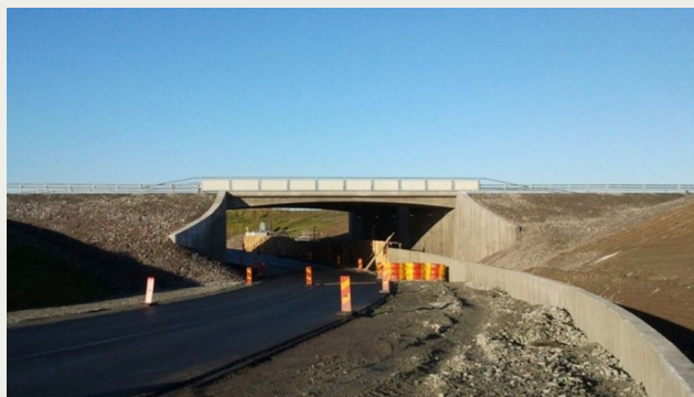
Figur 1. Bygge av plattrambro.
