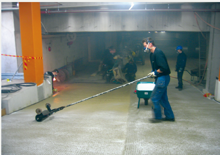
Bild 1. Vid läggning med varm gjutasfalt tvingas montörerna bära mask vid inomhusläggning.
