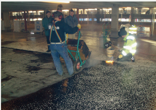
Bild 5. Arbete på P-däcket i Huddinge. Ingen nämnvärd rökutveckling.
