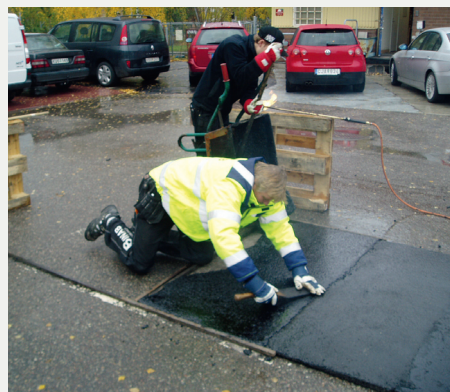
Bild 4. Referensläggning för hand i samband med test av Flytcylindermetoden.
