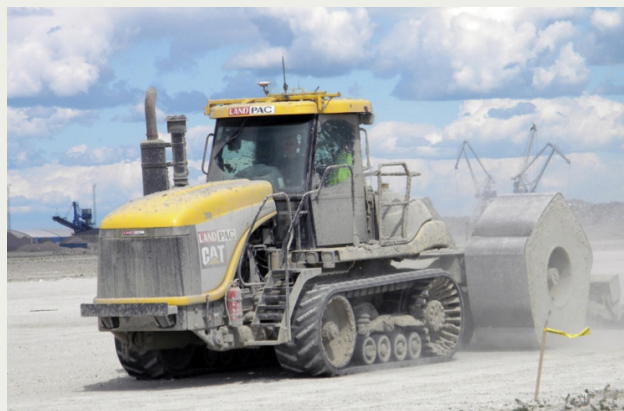
Figur 1. Aktuell Landpac-vält under packningsarbetet i Norra Hamnen.
