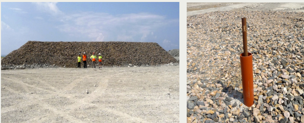
Figur 3. Foton visande en av provbankarna samt den övre delen av en av markpegelarna som användes för sättningsuppföljningen.
