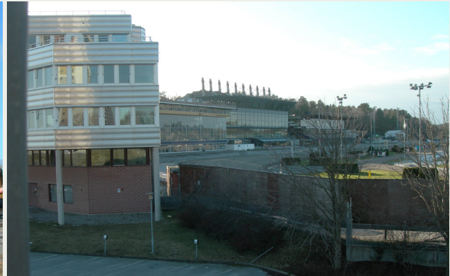
Figur 3. Arbetet med schaktning och spontning för utbyggnaden (till vänster) utfördes bara några meter från travbanan. Foto: Johan Spross.
