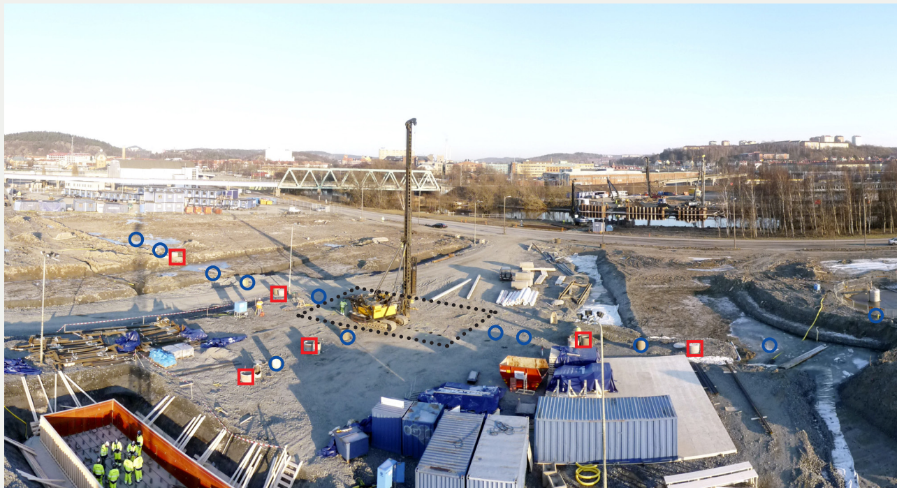
Vy över fältmätningarna vid påslagning för brostöd A11. Till vänster i förgrunden syns gjutformen för brostöd A10. Cirkelsymboler = lägen för markpegel Kvadratsymboler = lägen där såväl markpegel, inklinometrar som bägslangor installerats.
