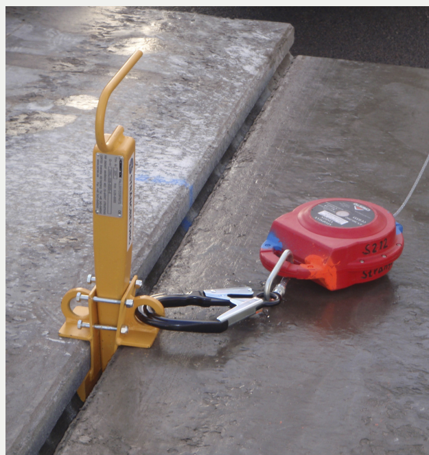
Figur 1. Strängbetongklämman i springan mellan två HDF-plattor.
