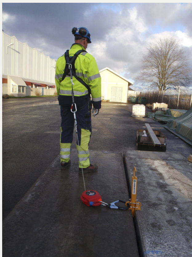
Figur 2. Användning av Strängbetongklämman.
