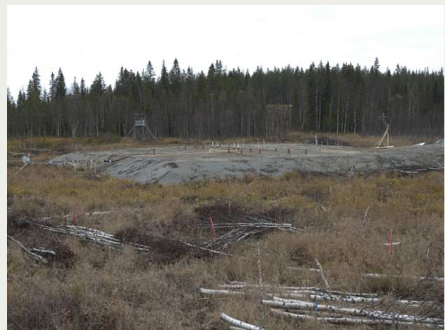
Figur 5. Bank 1 vid färdigställandet av 1,5 m bankhöjd.
