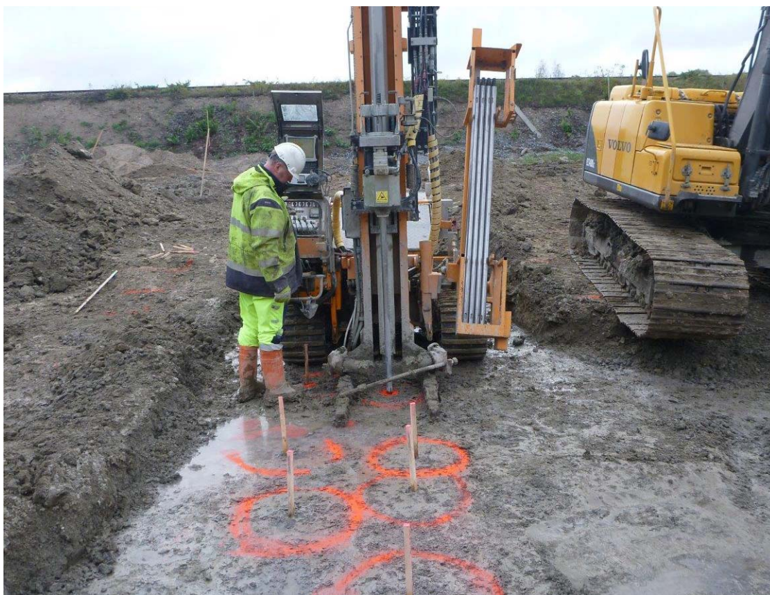
Figur 3. Bilder tagna när pelarna sonderas.
