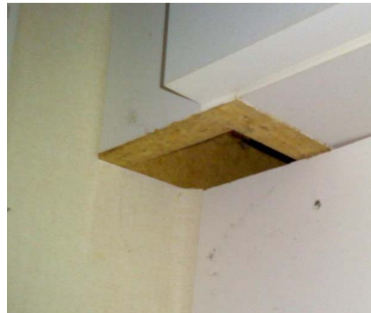
Termogram 8. Stort luftläckage förekommer mellan garderob och vägg jämte schaktet. Det vanliga fotot visar underifrån öppning upp mellan garderob och vägg varur kraftig luftström känns. Detta läckage torde ha funnits även juli 2013, men syntes då ej i värmekameran.
