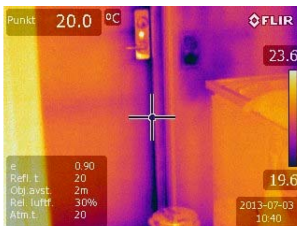
Ytterdörr till tvättstuga vid mätning 1, juni.
