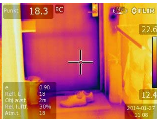
Ytterdörr till tvättstuga vid mätning 4, januari.
