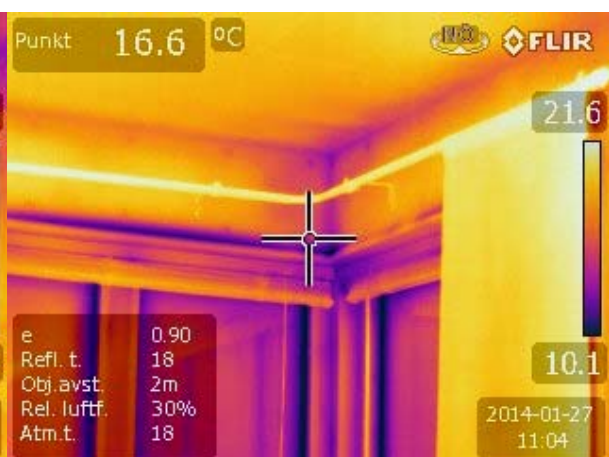
Ovan fönster i burspråk vid mätning 4,
