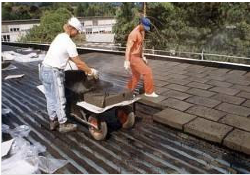
Figur 73. Läggnig av Foamglastak.
