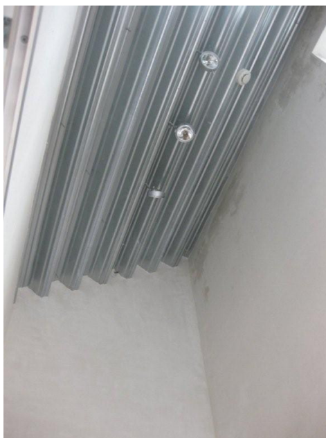
Figur 71. På BoDagarna som var i Åhus 4-13 september 2009 visades bland annat detta hus med trp-tak enligt CTEN. Plåten gör det möjligt att bygga tak med annat utseende, här är plåten upplagd på CTEN-väggelement.
