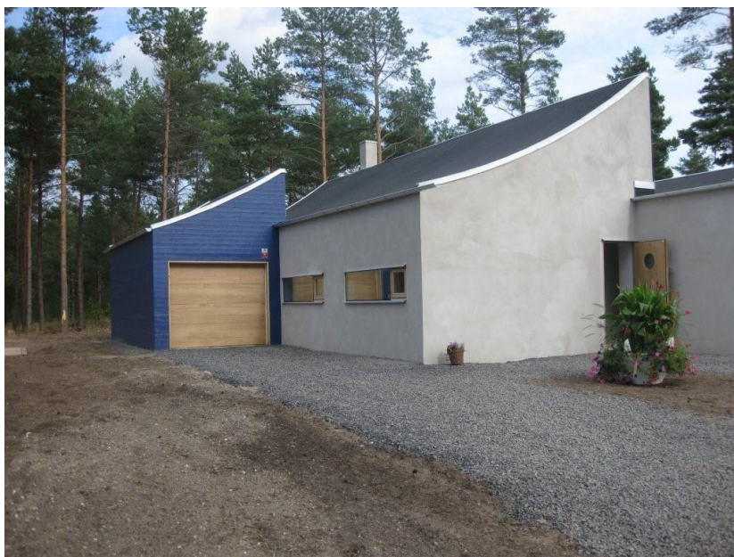
Figur 71. På BoDagarna som var i Åhus 4-13 september 2009 visades bland annat detta hus med trp-tak enligt CTEN. Plåten gör det möjligt att bygga tak med annat utseende, här är plåten upplagd på CTEN-väggelement.
